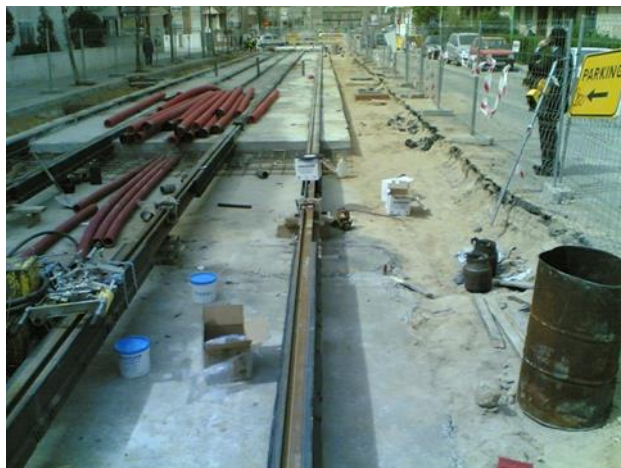
Figura 10 - Foto esempio delle operazioni di saldatura con procedimento alluminotermica
