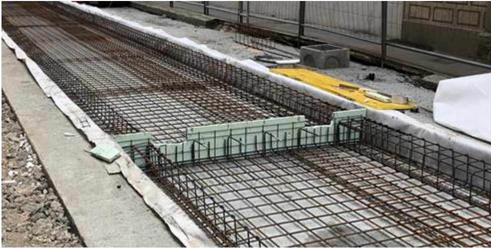
Figura 13 - Giunto di costruzione trasversale
