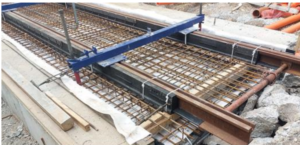
Figura 11 - Installazione rotaie con portalini
