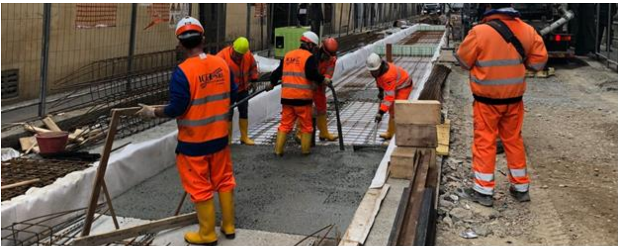
Figura 14 - Getto calcestruzzo di bloccaggio del materassino
